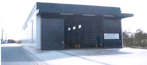
大口処分場(積替保管施設)
